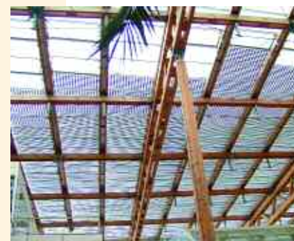
Abb. 2.3.2-1: Beispiel einer PV-Anlage mit unterschiedlichen Belegungsichten von Zellen.
