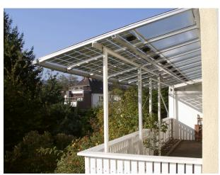
Überdachungen von Carports, Terrassen und Balkonen verbaut mit Solarglas in Glas-Glasausführung, mit Einscheibensicherheitsglas (ESG) oder Verbundsicherheitsglas (VSG).
